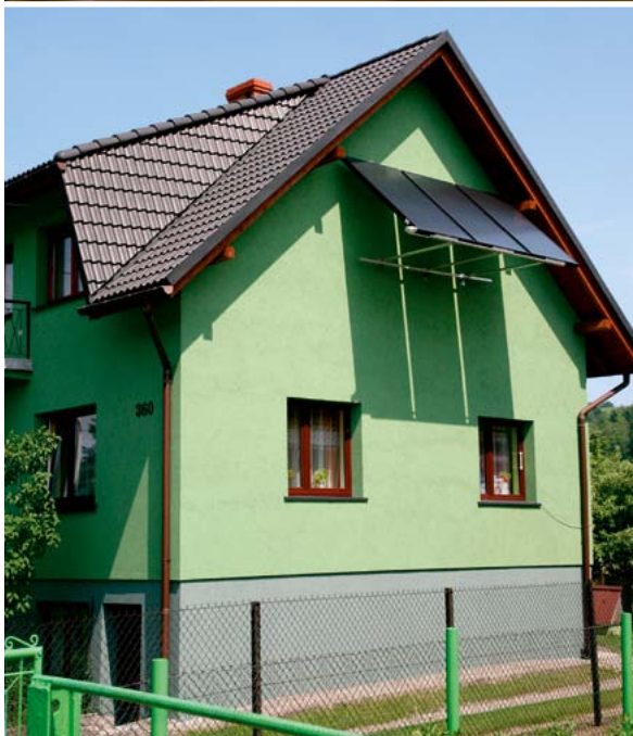
↑ Kolejny wariant montażu kolektora – na balkonie
