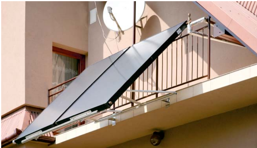
↑ Kolejny wariant montażu kolektora – na balkonie
